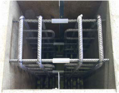
Figura 10. Vista interior de la probeta antes de hormigonar.
