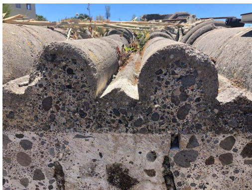
Figura 8. Detalle de la moldura prefabricada, columna de crucero. Restos de la Catedral. Fotografía de Hugo Ventura Rodríguez.
