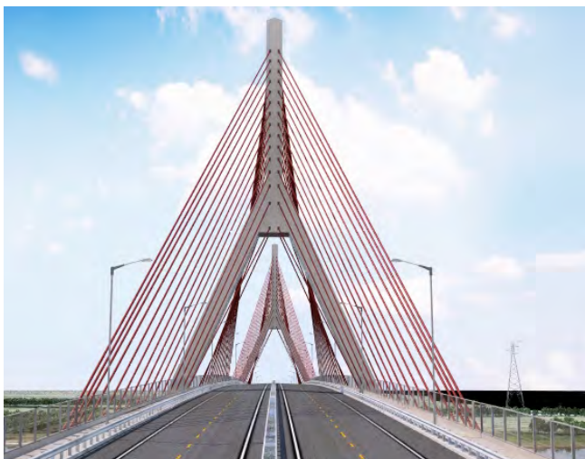
Figura 15. Imagen del atirantamiento visto desde la calzada.
