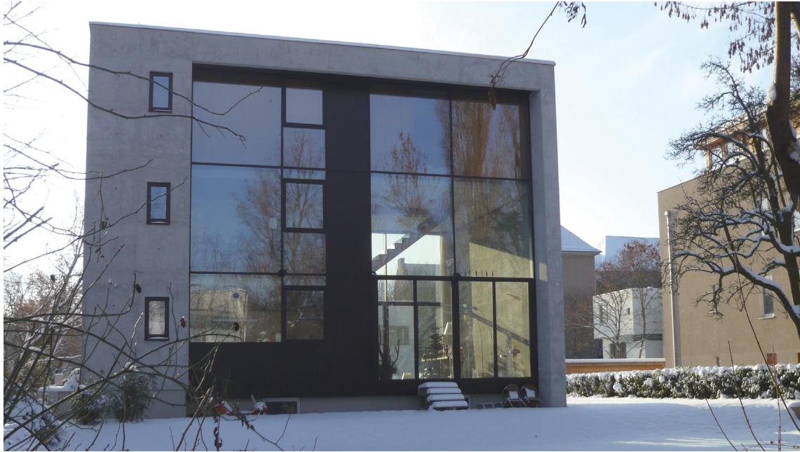
Fig. 1. Casa construida con hormigón infraligero en Berlín-Pankow (2007).
