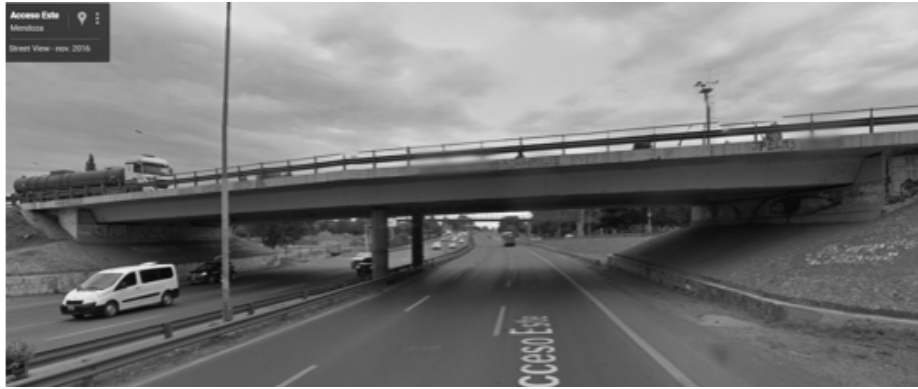
Figura 3a. Puente Acceso Este a Ciudad de Mendoza, Ruta Nacional 7 (dos puentes similares yuxtapuestos). Vista.
