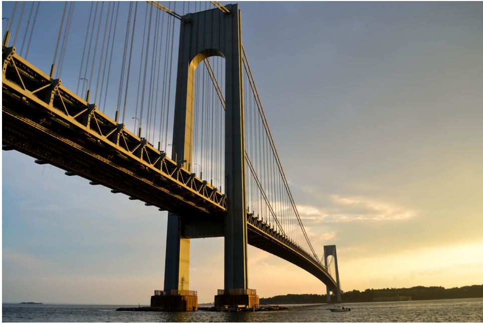
Figure 4. Verrazano Narrows Bridge, N.Y. USA.
