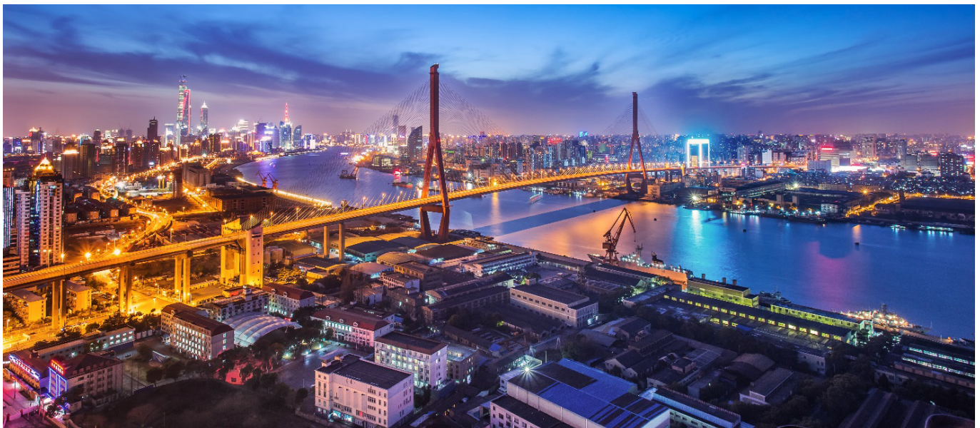
Figure 10. Yang Pu Bridge, Shanghai, China.
