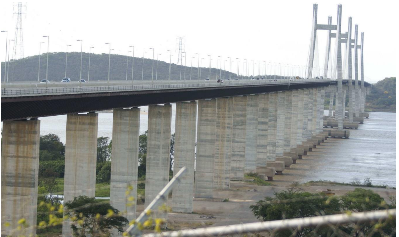
Figure 22. Orinico Bridge, Venezuela.
