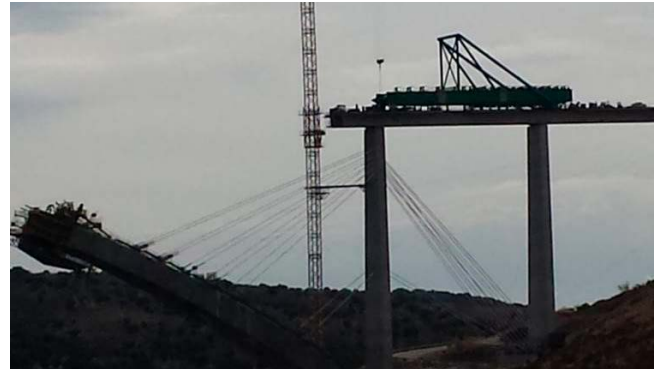
Figura 22. Fotografía torre en posición horizontal preparada para el inicio de la operación.
