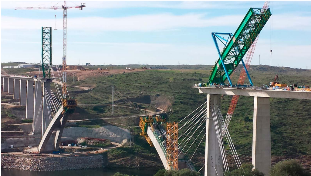
Figura 30. Vista torre en transferencia de carga.
