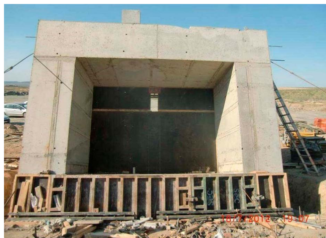
Figura 10. Frente dovela de prueba.
