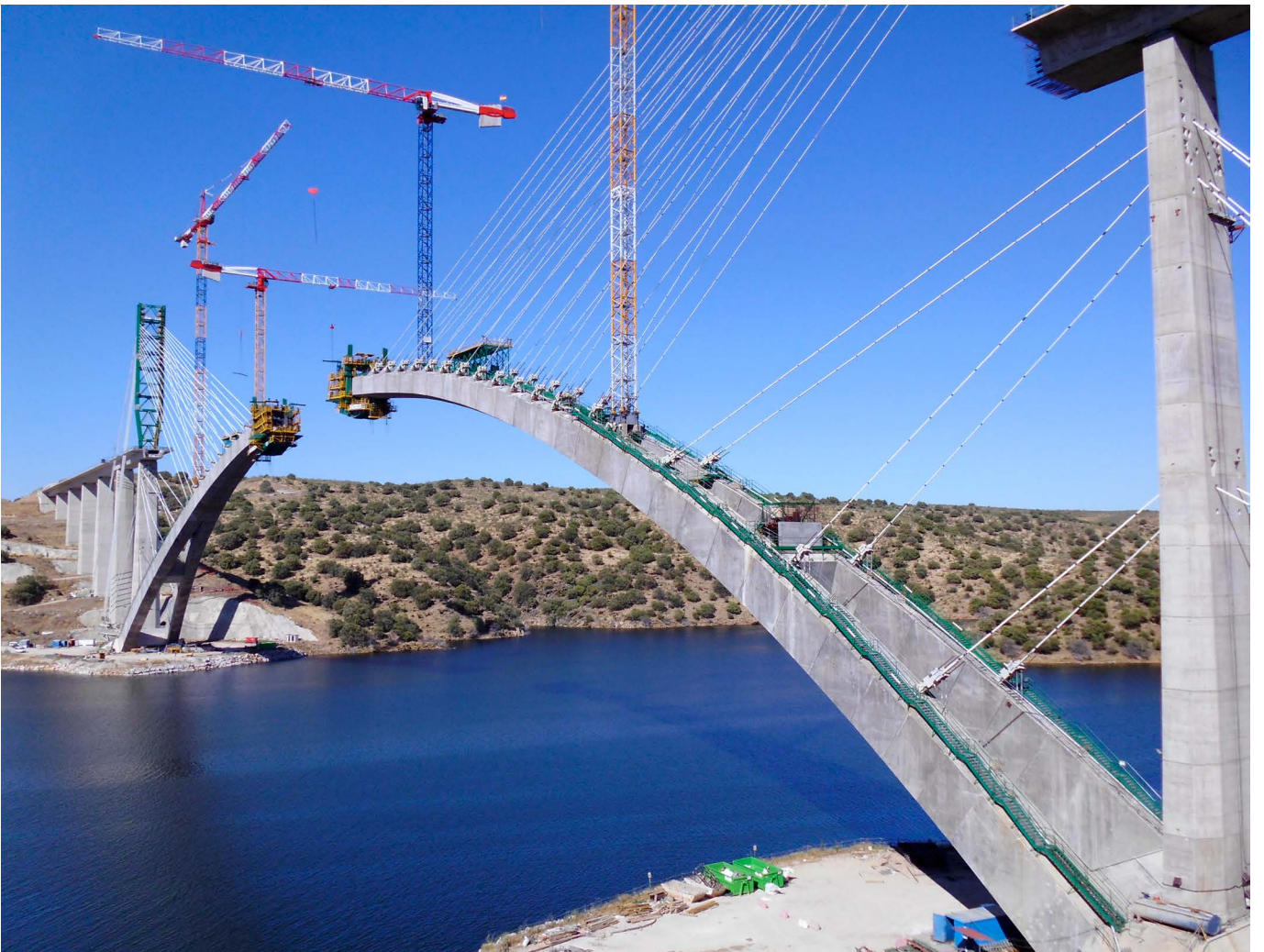
Figuras 1 y 2. Puente y voladizos.
