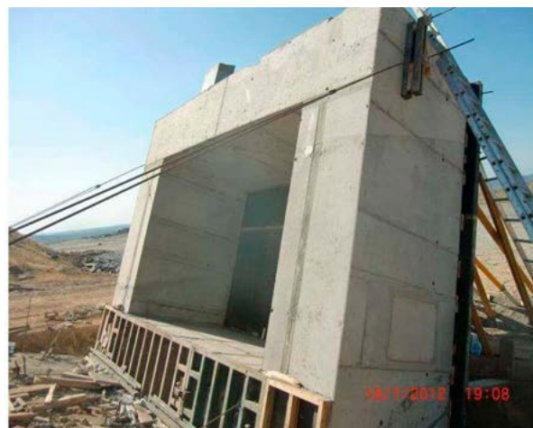
Figura 11. Dovela de prueba tras desmolde.
