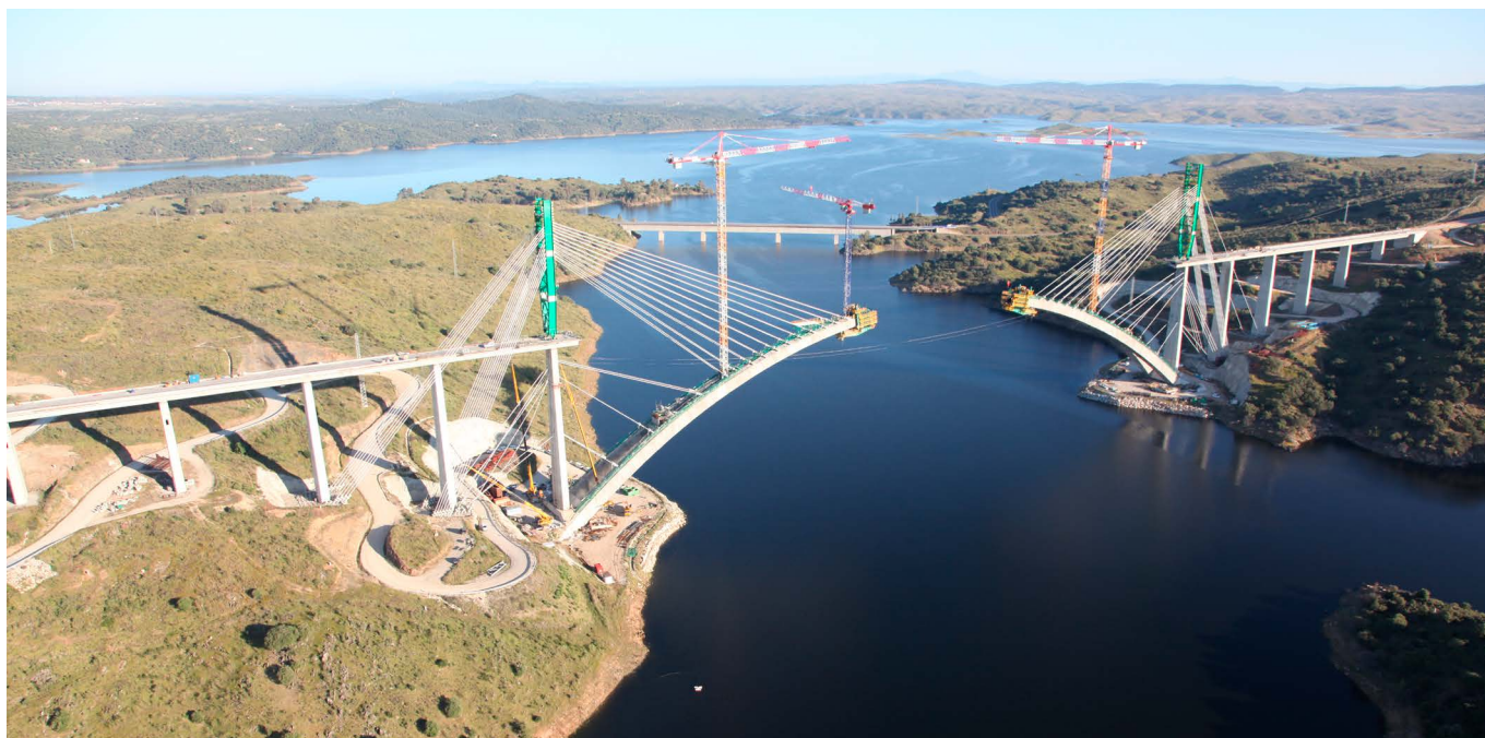
Figura 2. Ejecución del arco del viaducto de Almonte.
