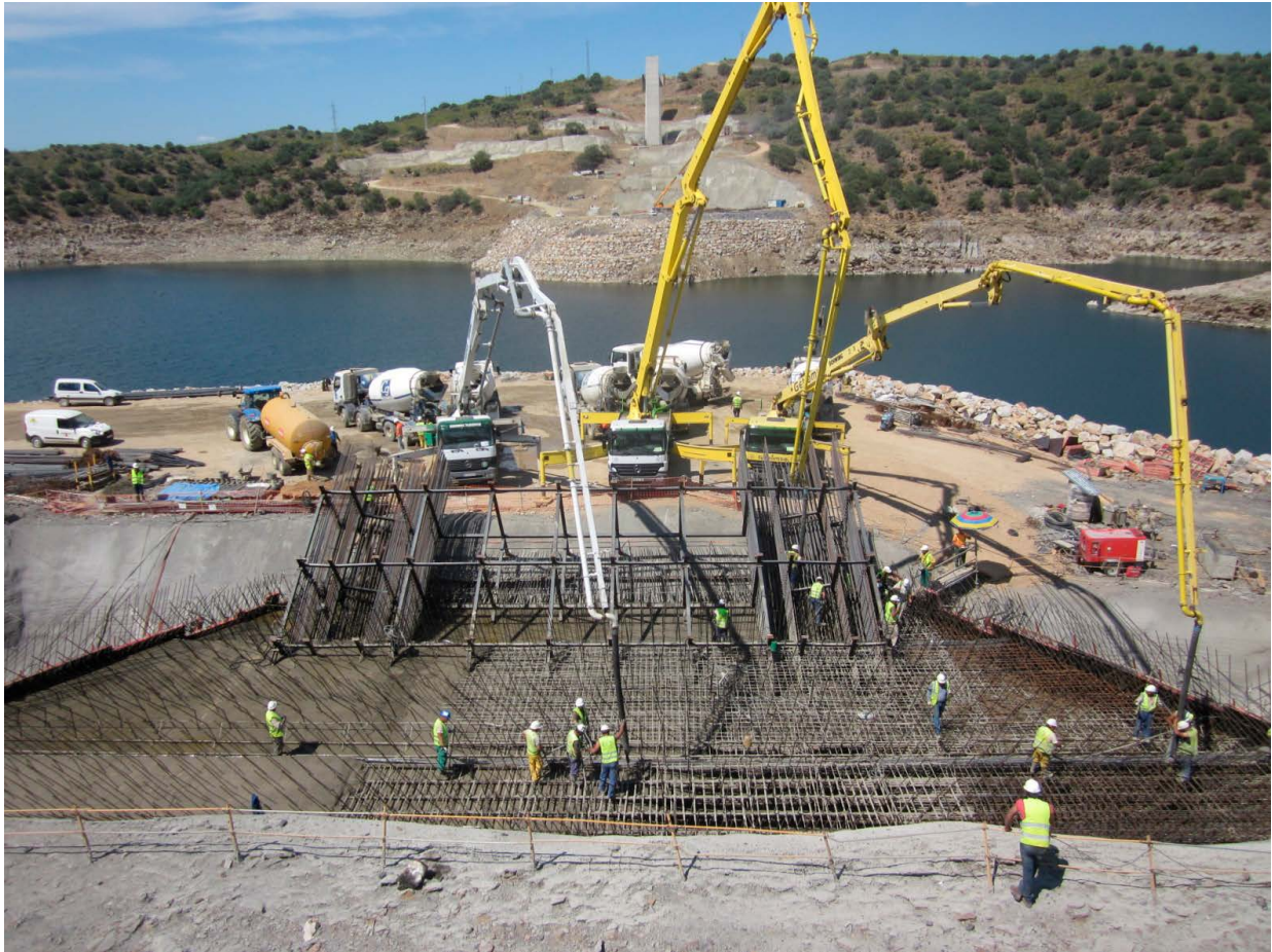
Figura 4. Fase 4 de hormigonado de la cimentación sur del arco.
