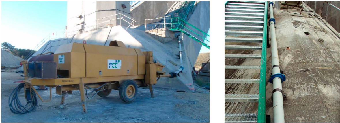
Figura 39. Bomba de hormigón e instalación de tubería a lo largo del arco del viaducto de Almonte.
