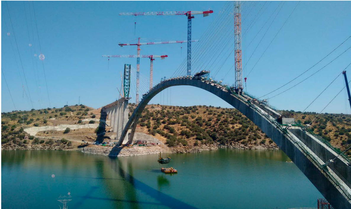
Figura 16. Descenso de los carros de la margen norte a pontona modular.
