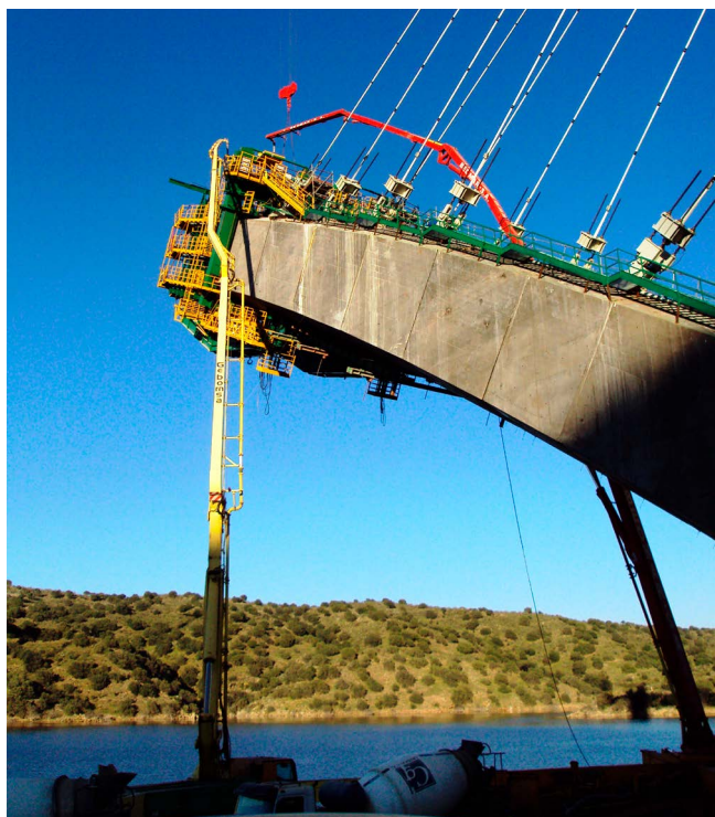
Figura 28. Hormigonado con autobomba de una dovela.
