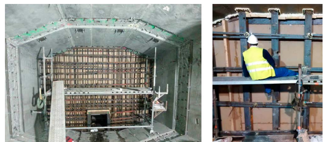
Figura 34. Ferrallado y encofrado del diafragma de la pilastra 9.
