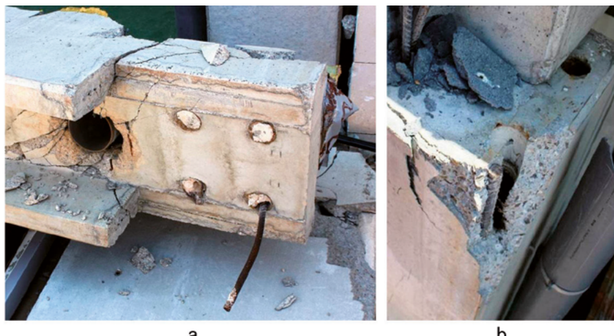
Figura 5. Problemas asociados a desviaciones por tolerancias.
