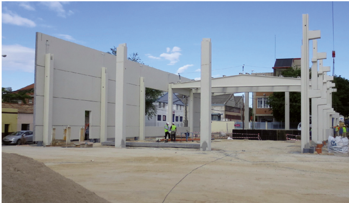
Figura 31. Nave en construcción con elementos prefabricados.
