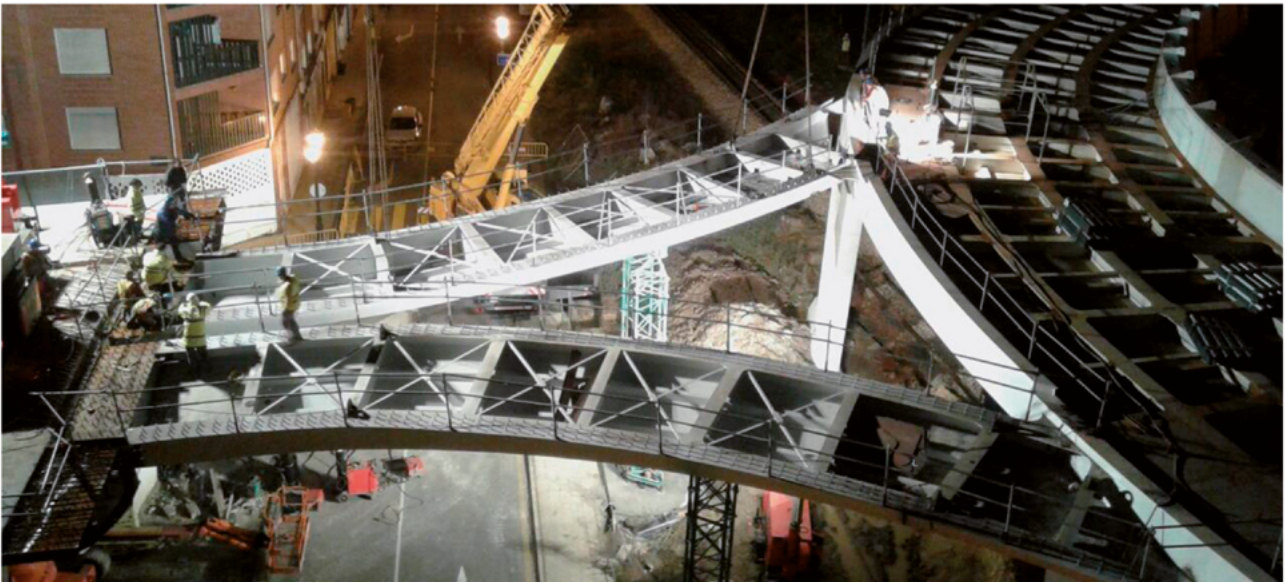
Figura 13. Montaje de los vanos intermedios.
