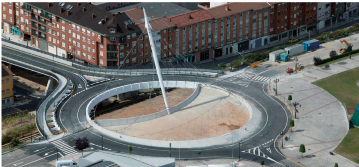
Figura 15. Vista superior de la estructura desde La Florida.
