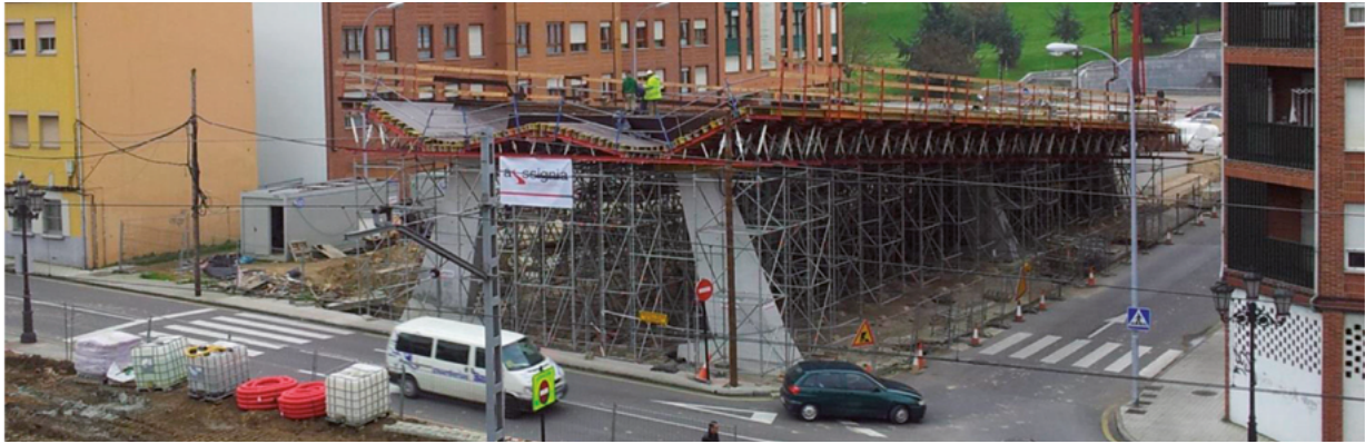
Figura 12. Cimbra y encofrado del viaducto de acceso.
