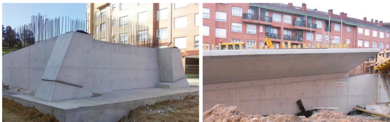
Figura 6. Fotografías del estribo E1 y muro de acompañamiento.
