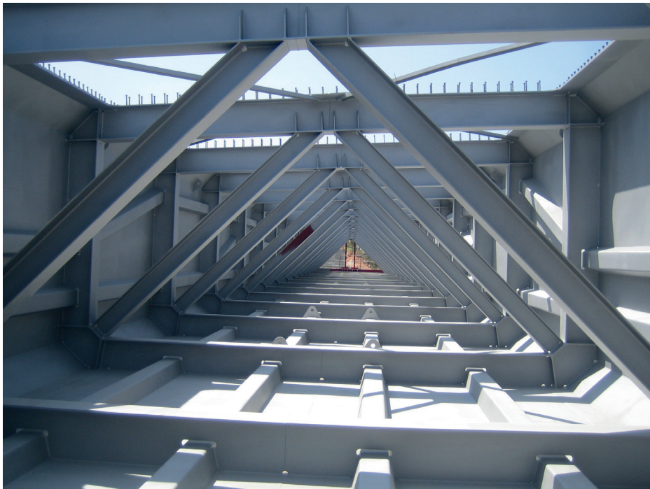
Figura 1. Sección formada por placas esbeltas rigidizadas.
