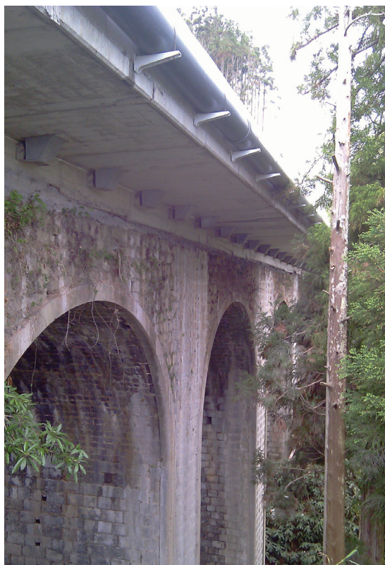
Figura 17. Vista parcial de la estructura terminada.
