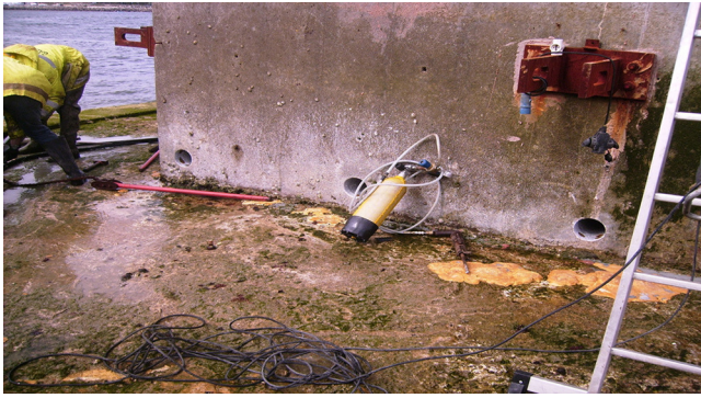
Figura 15. Refuerzo de la cimentación de las pilas laterales. Operaciones de perforación.
