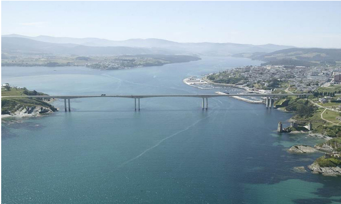
Figura 1. Vista general del puente de Los Santos antes del comienzo de los trabajos de ampliación.
