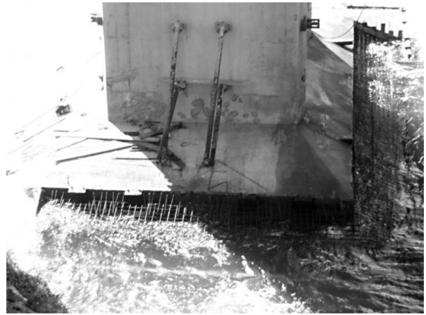
Figura 18. Construcción del zuncho perimetral de pila 4.
