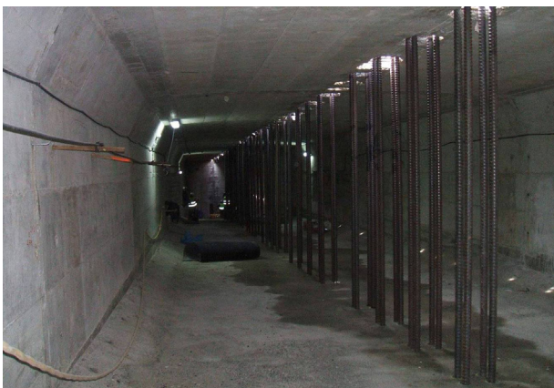
Figura 22. Fotografía de las barras de cortante del alma central. Obsérvense los taladros de la losa superior, realizados mediante hidrodemolición, para evitar daños en la armadura de la losa superior necesaria para las nuevas cargas.
