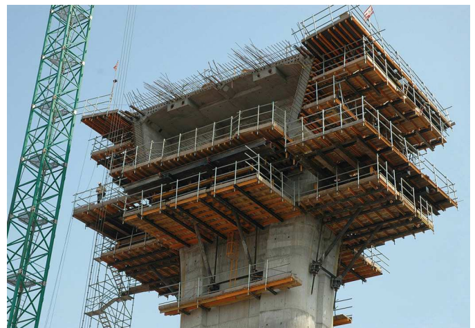
Figura 8. Plataformas de trabajo de dovela cero.
