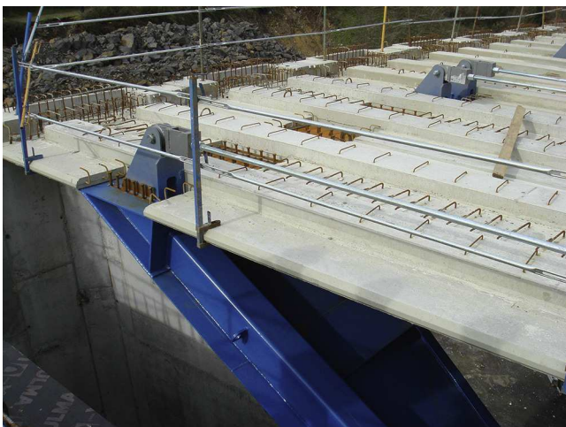
Figura 14. Viaducto principal. Prelosas colocadas.
