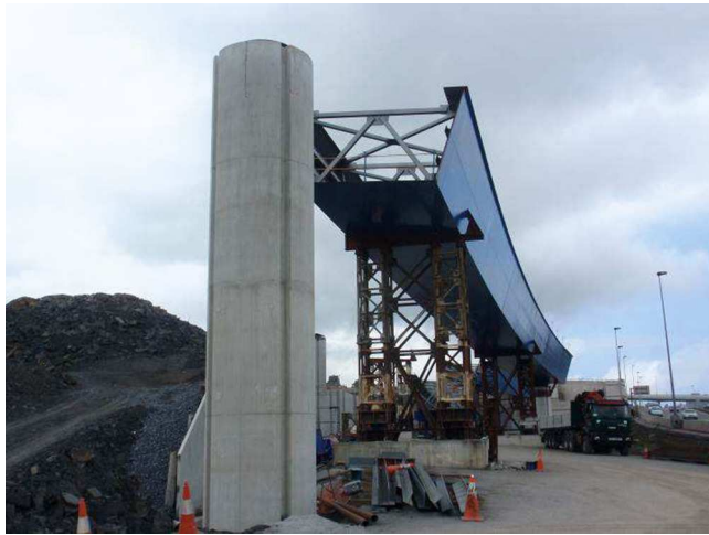
Figura 28. Pilas de los ramales de acceso.
