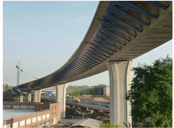
Figura 6. Vista general del viaducto principal.
