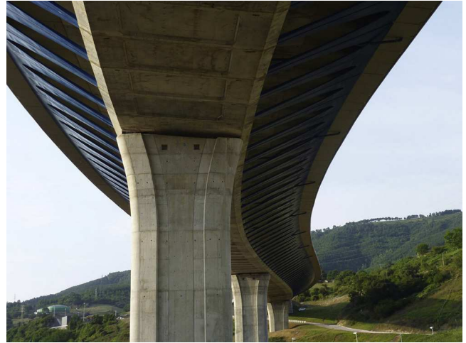
Figura 12. Viaducto principal. Vista inferior.
