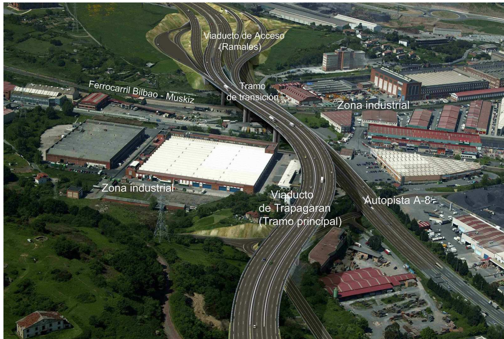
Figura 1. Imagen virtual de la zona del viaducto.
