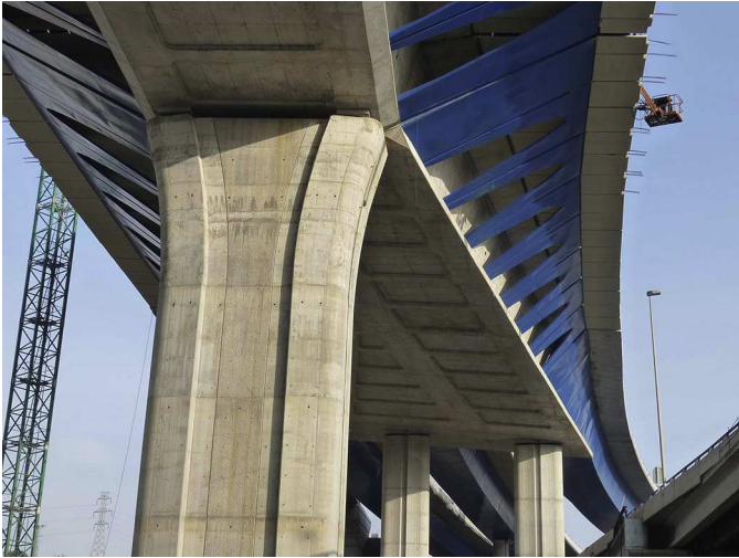
Figura 23. Vista inferior de la zona de transición.
