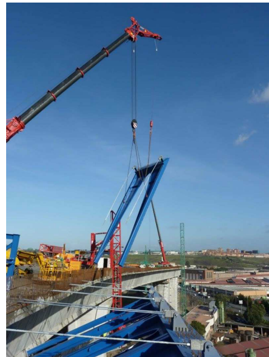
Figura 15. Viaducto principal. Montaje de jабalcones.
