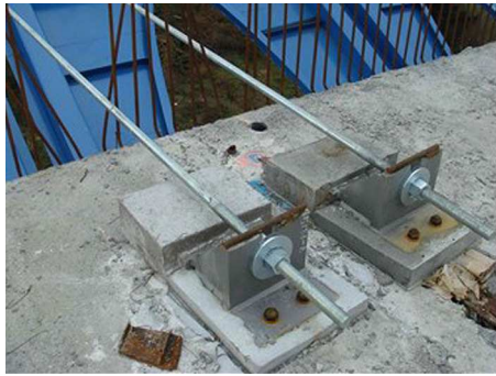
Figura 13. Viaducto principal. Tacos de sujeción en núcleo.
