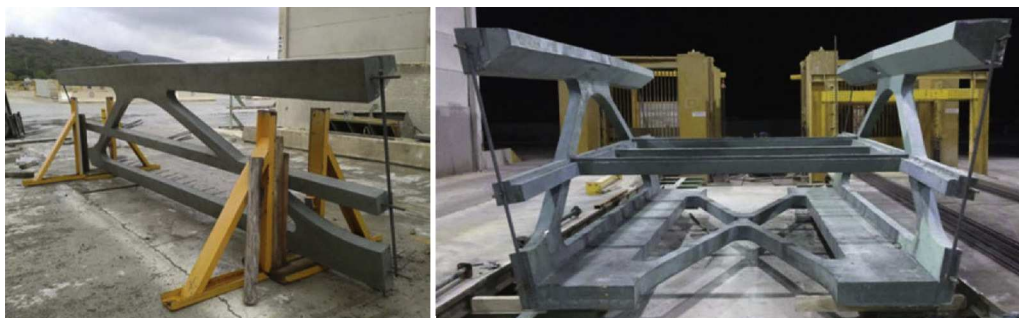
Figura 20. Prototipo de verificación del proceso de construcción.
