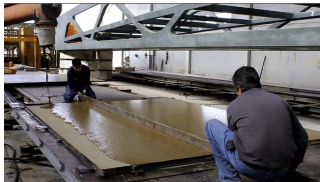
Figura 27. Fabricación de las losas con HMAR ocre.
