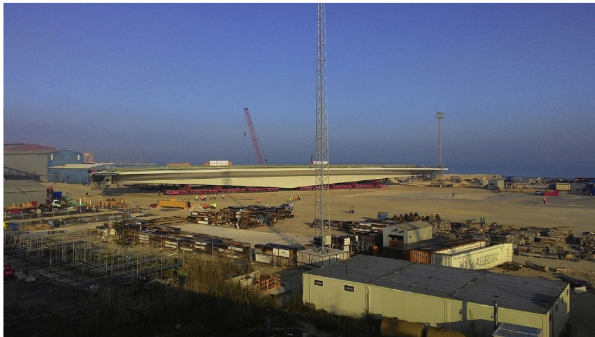
Figura 9. Transporte terrestre del tramo desmontable.
