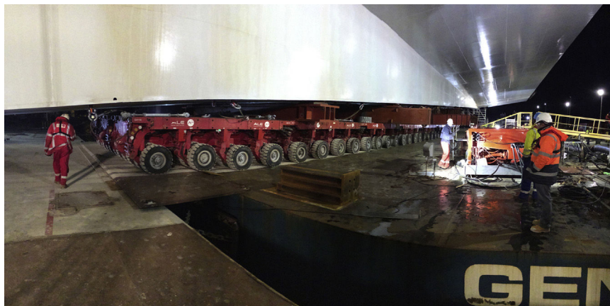
Figura 11. Embarque del tramo desmontable en la pontona.
