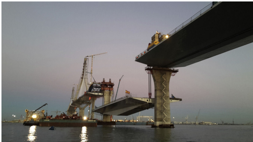
Figura 15. Izado del vano desmontable.
