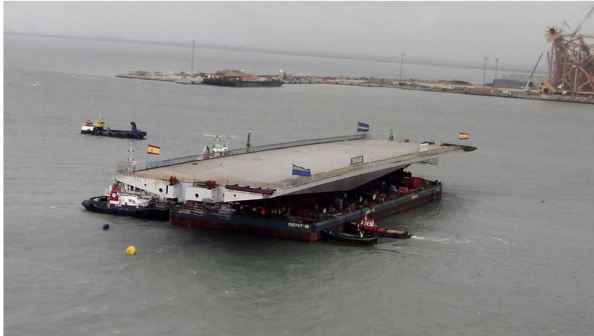
Figura 12. Transporte por mar del tramo desmontable.
