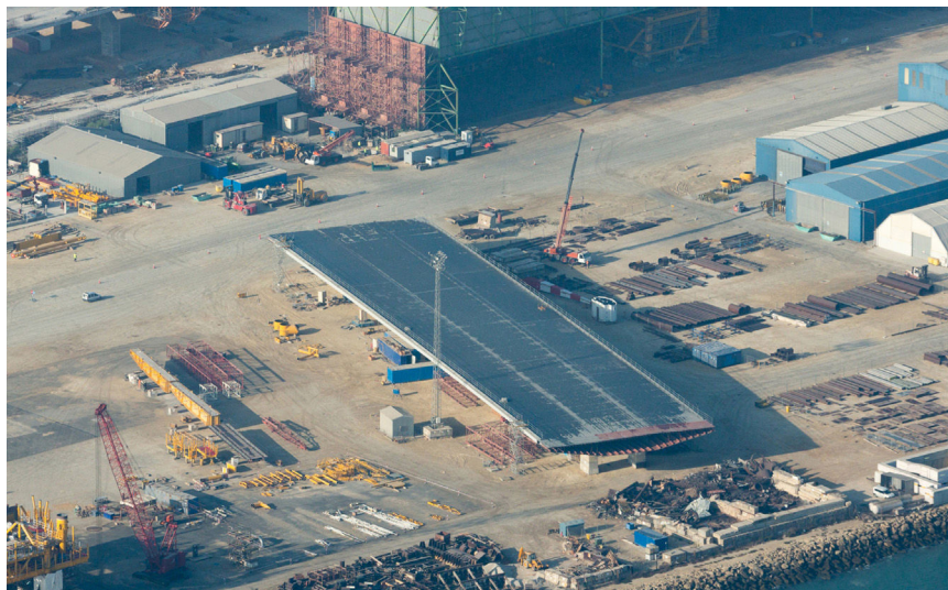
Figura 7. Tablero del vano desmontable sobre apeos de fabricación.
