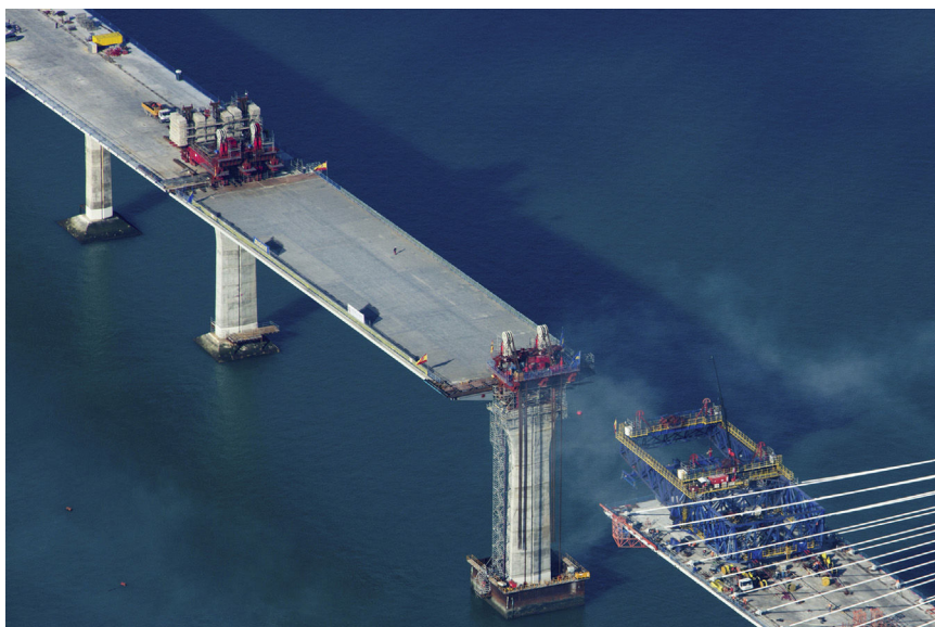
Figura 17. Vano desmontable apoyado en posición definitiva.
