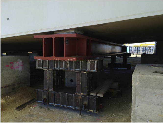
Figura 8. Apeos para pesaje del tramo desmontable.
