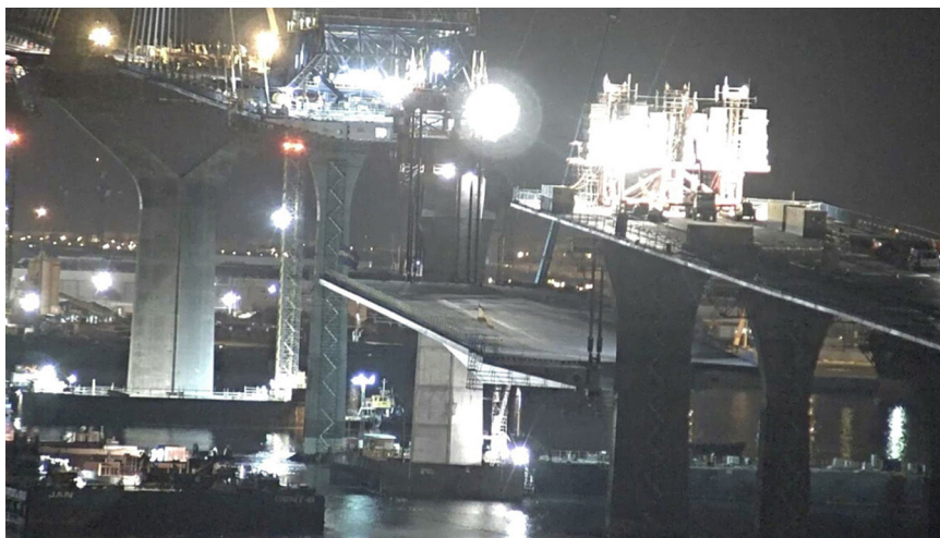
Figura 16. Giro del 5% del vano desmontable.
