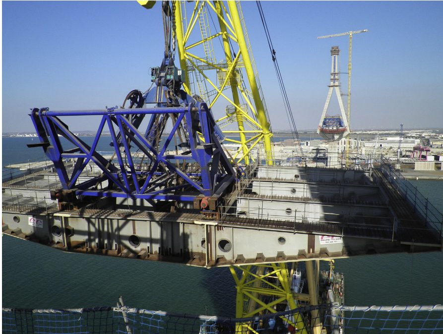
Figura 3. Izado con pescante y dispositivo de nivelación.
