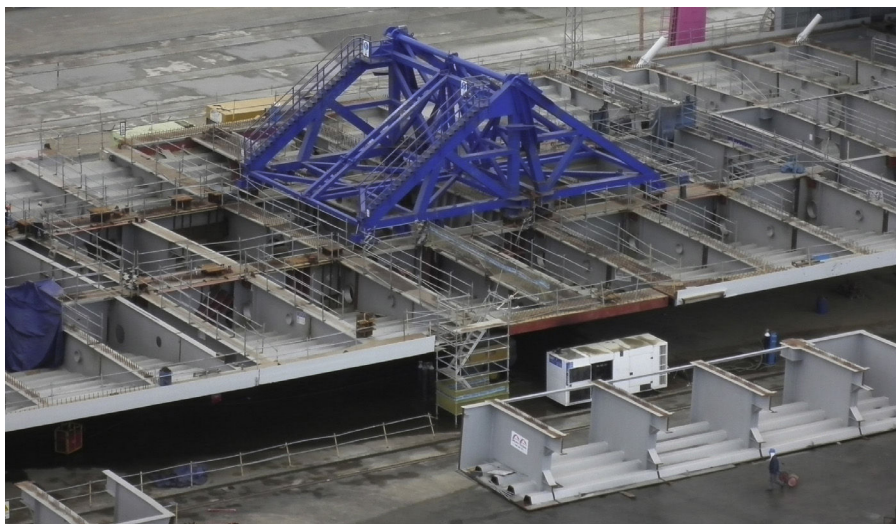
Figura 6. Dispositivos de cuelgue en montaje en blanco.
