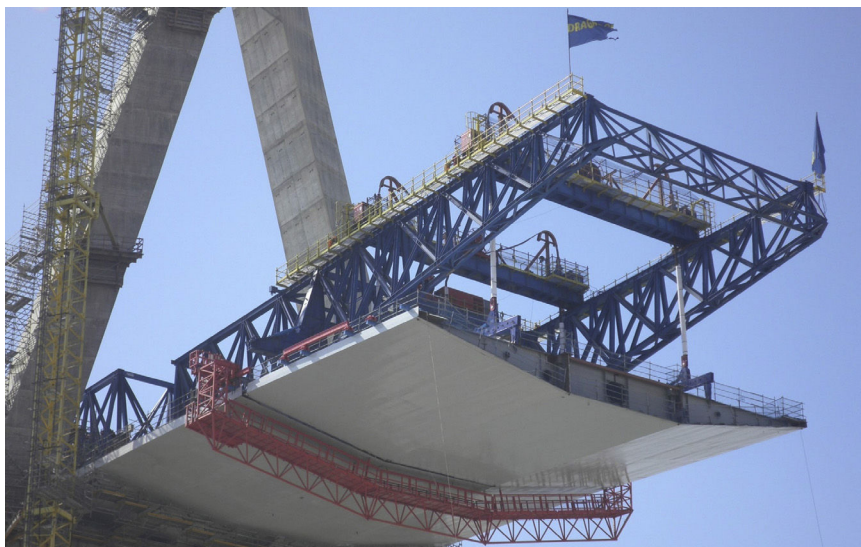
Figura 21. Carro de izado y plataforma de soldadura.
