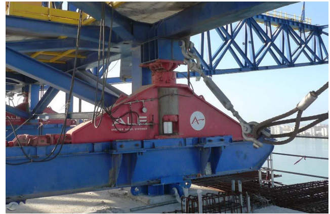
Figura 15. Patín de deslizamiento y viga carril.
