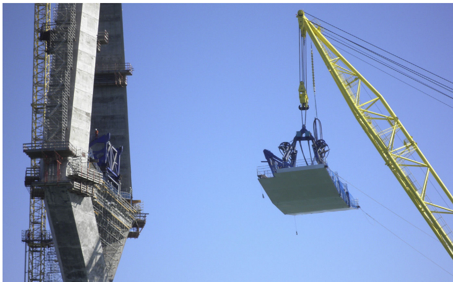
Figura 5. Aproximación con dispositivos de cuelgue en pila 12.
