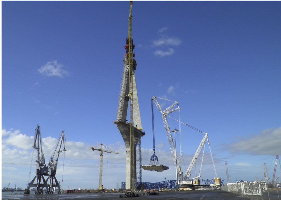
Figura 1. Izado de la dovela «0» de la pila 13.
