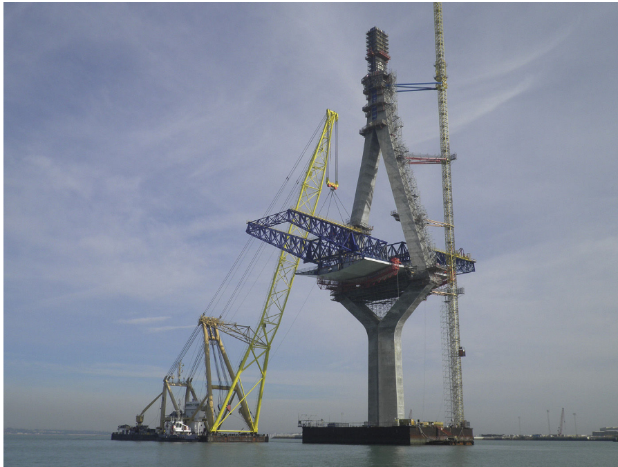
Figura 9. Instalación de carros de izado en la pila 12.
