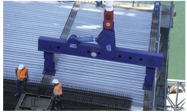
Figura 16. Balancín de regulación.
