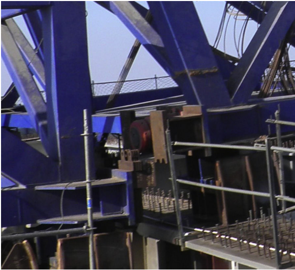
Figura 7. Pescante. Detalle gato y galgas inferiores.
