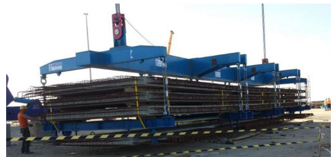
Figura 17. Paquete de losas y balancín de izado.
