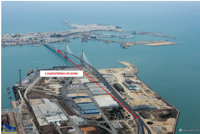
Figura 6. Vista aérea de la longitud del tablero sin juntas.
