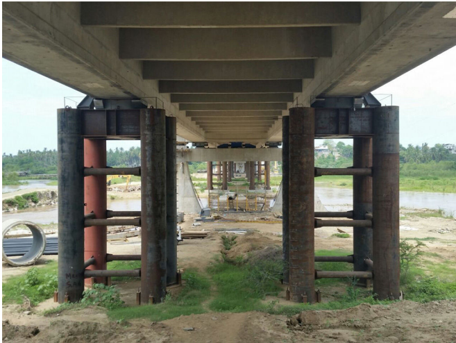
Figura 6. Vista inferior del tablero y apoyos provisionales con los balancines para el empuje.
