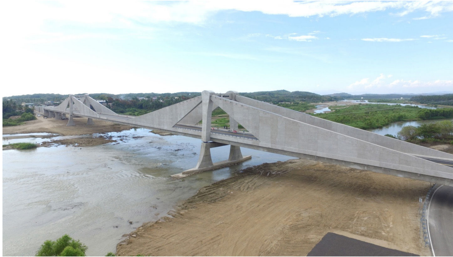
Figura 1. Vista general del puente.
