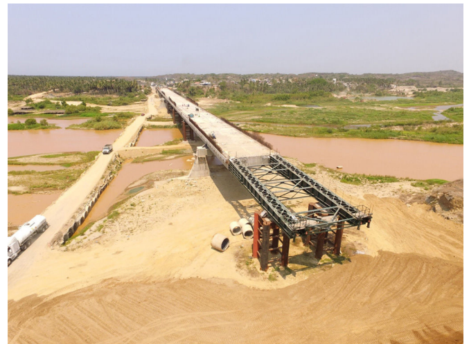
Figura 3. El tablero durante el empuje.
