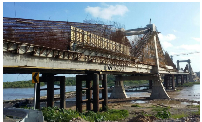
Figura 9. Las velas durante la construcción.
