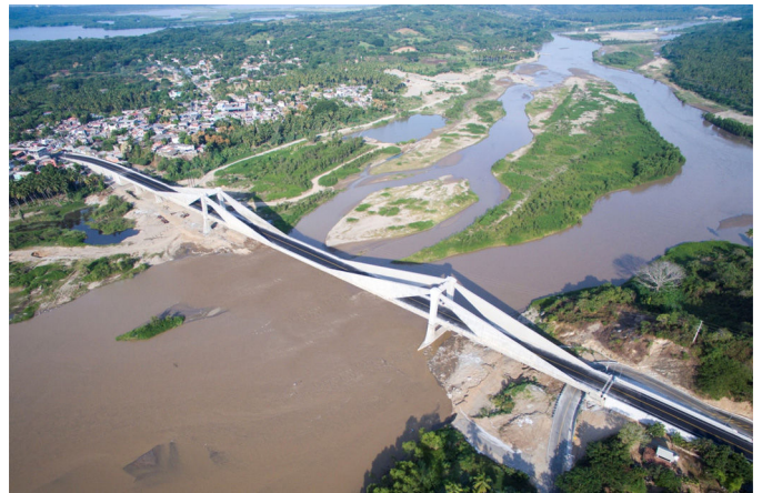
Figura 14. Vista aérea del puente terminado.
