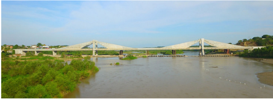
Figura 13. El puente terminado antes de retirar los apoyos provisionales.
