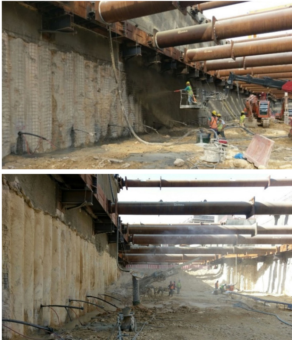
Figura 8. Fases de colocación de los anclajes activos en la estación 3E1.
