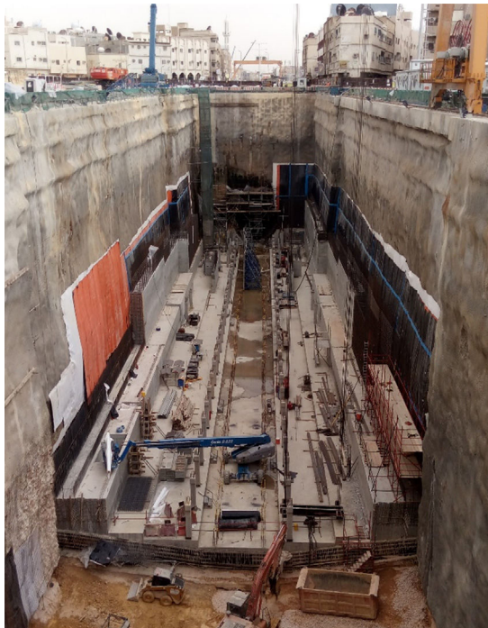
Figura 19. Módulos 1 a 3 de la contrabóveda finalizados.
