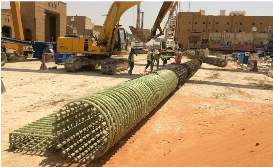
Figura 6. Armadura de fibra de vidrio.
