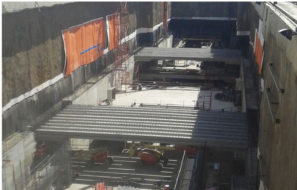
Figura 2. Colocación de vigas prefabricadas del nivel inferior.
