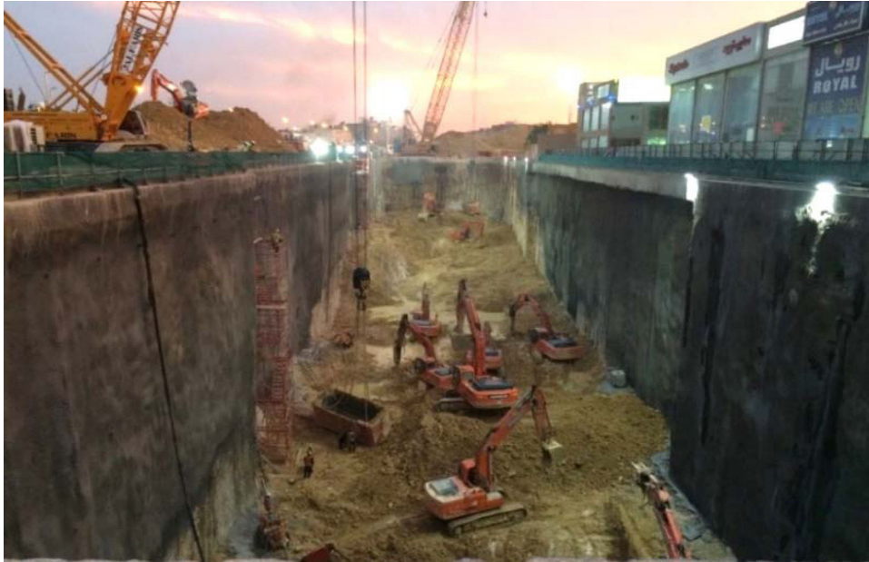
Figura 5. Trabajos de excavación en una estación profunda.
