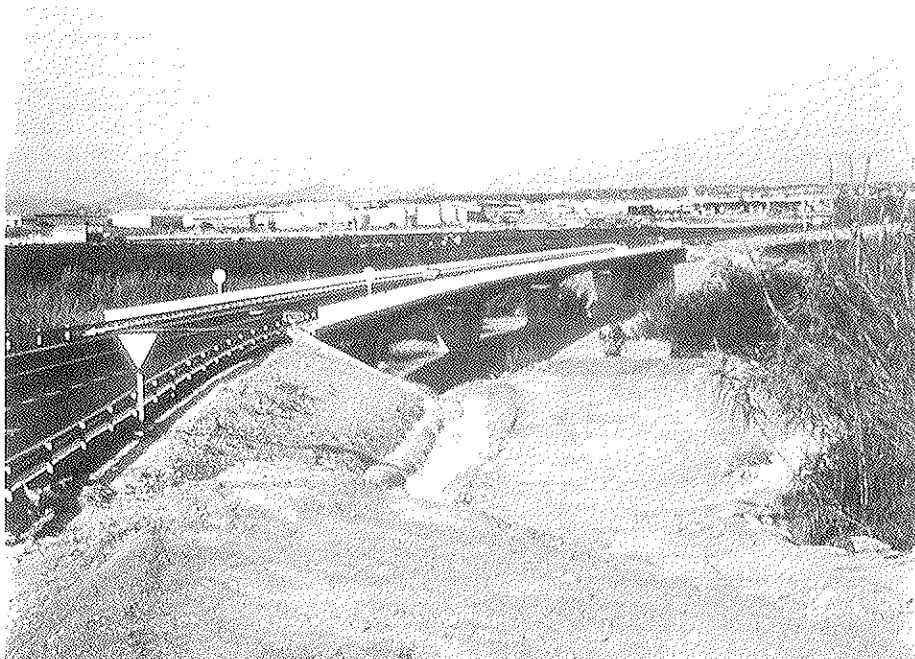
Fig. 1. Vista General del Puente.
