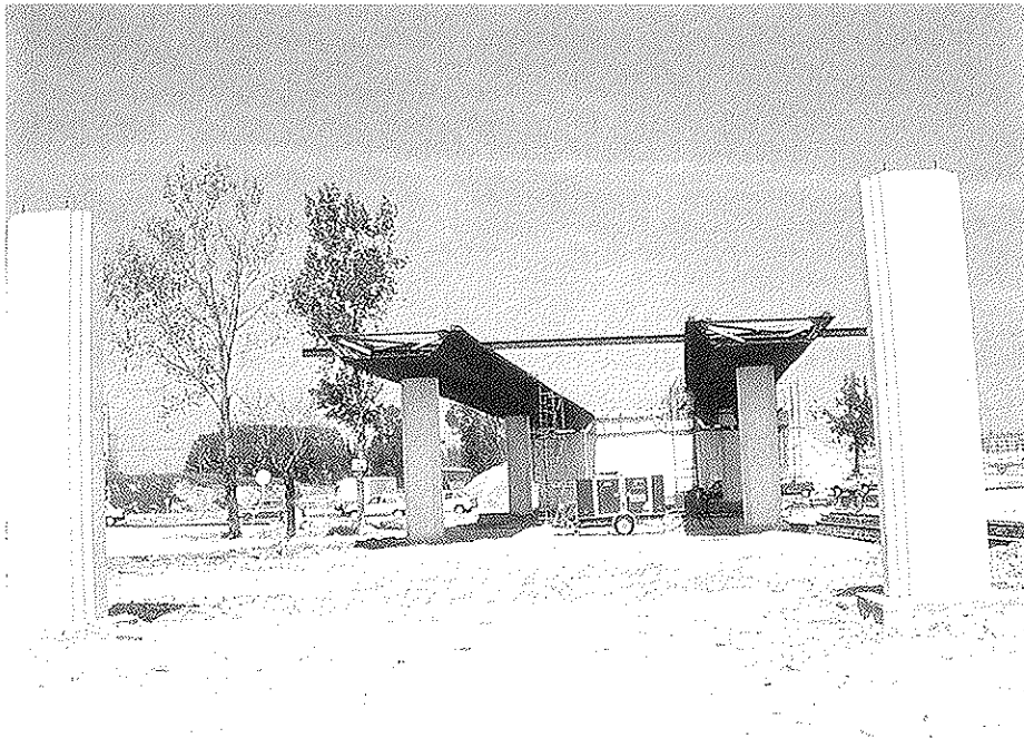
Fig. 26. Fase de Montaje.
