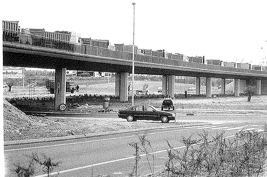
Fig. 28. Alzado Lateral durante Prueba de Carga.
