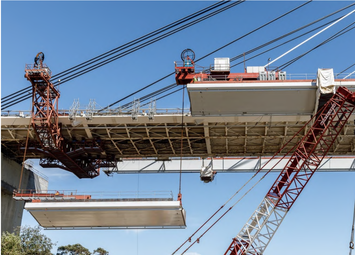
Figura 21. Dovela de la ampliación del tablero durante el izado. Puente de Rande ampliado.
