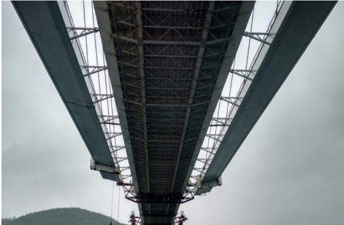
Figura 18. Vista inferior del tablero original durante la construcción de la ampliación.
