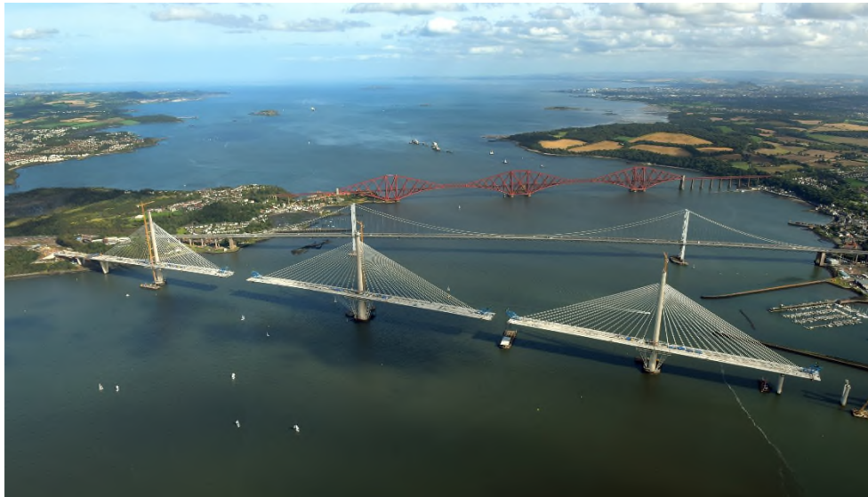
Figura 10. Vista de los tres puentes del estuario del Forth. Queensferry Crossing.
