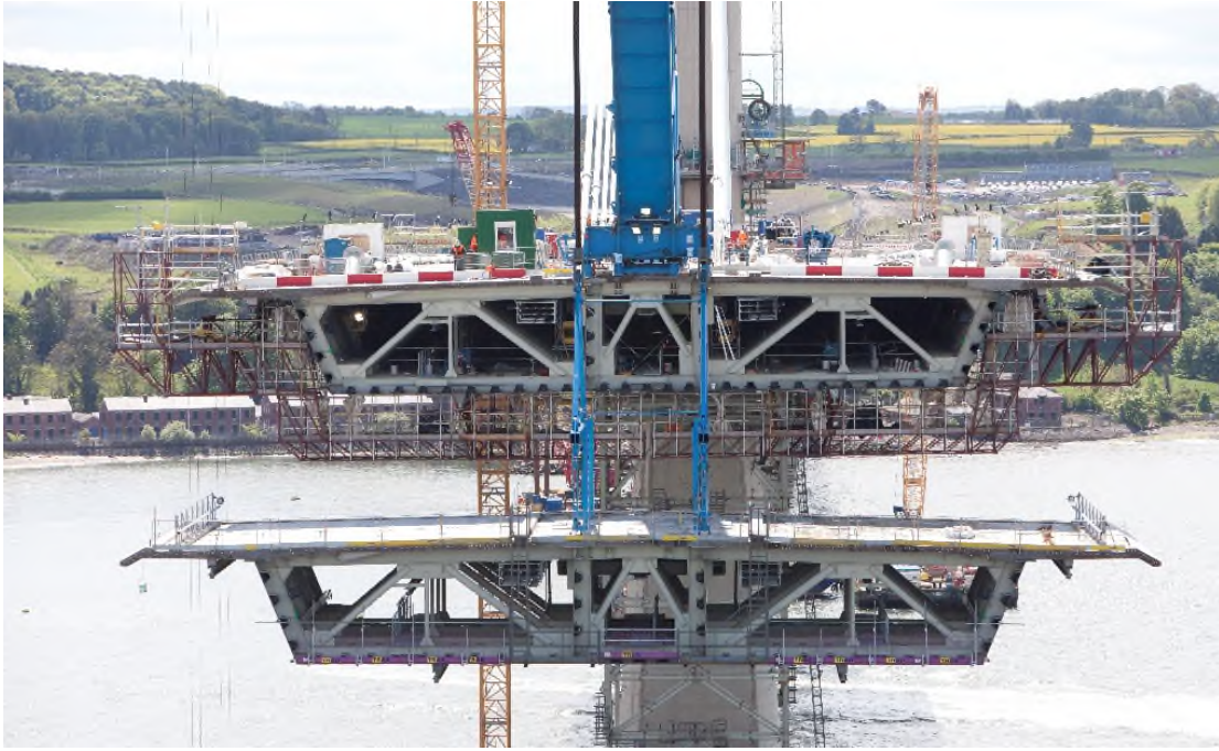
Figura 14. Carro izando una dovela del tramo atirantado. Queensferry Crossing.
