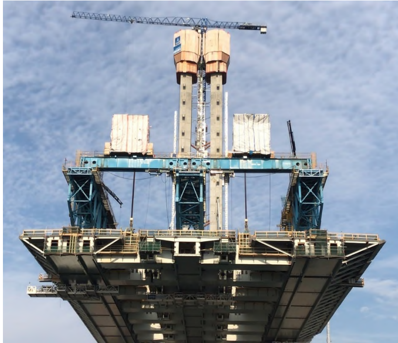
Figura 32. Vista frontal del tablero con el carro de izado de dovelas. Puente de Champlain.
