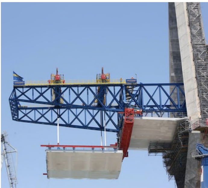
Figura 5. Izado de dovela tipo. Puente de la Constitución de 1812.
