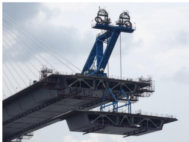
Figura 16. Izado de una dovela del tramo atirantado. Queensferry Crossing.
