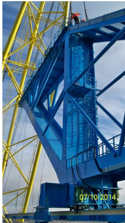
Figura 13. Carro izado dovelas. Queensferry Crossing.
