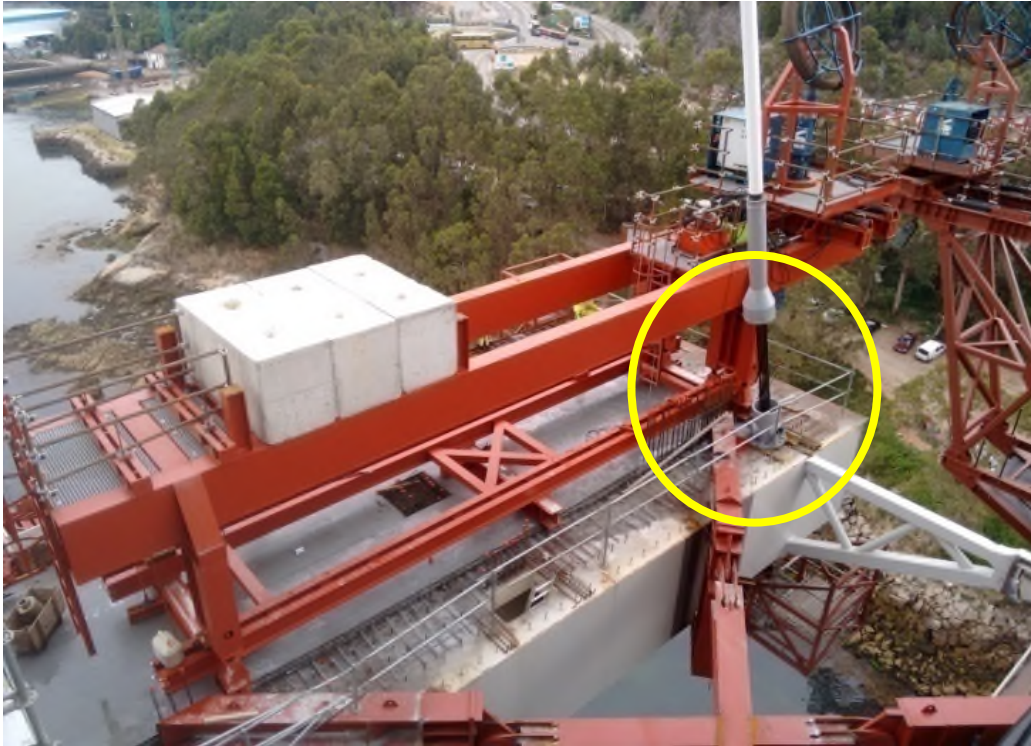
Figura 22. Carro de izado trasero empleado en la ampliación del Puente de Rande.
