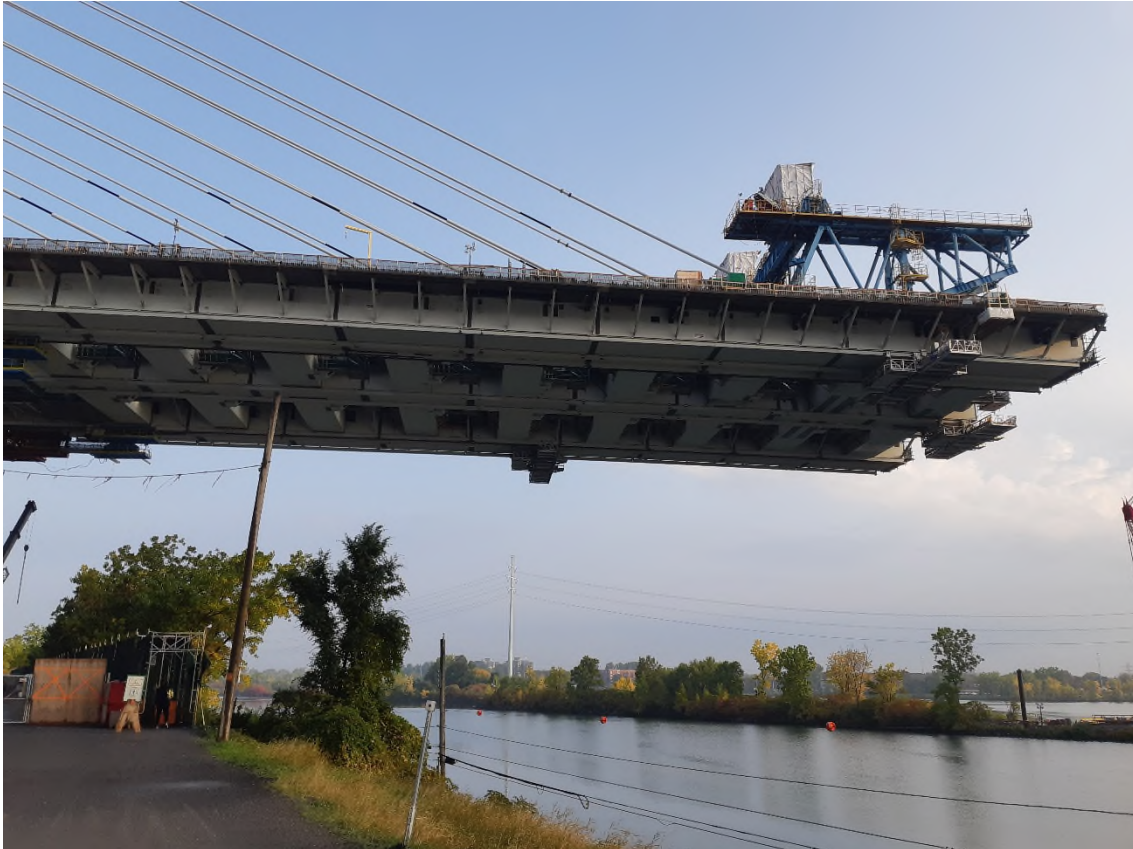
Figura 31. Vista del Seaway durante el avance en voladizo. Puente de Champlain.
