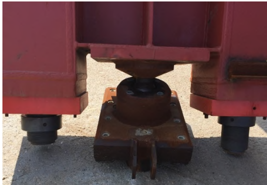
Figura 23. Sistema de apoyo doble del carro trasero. Ampliación del Puente de Rande.
