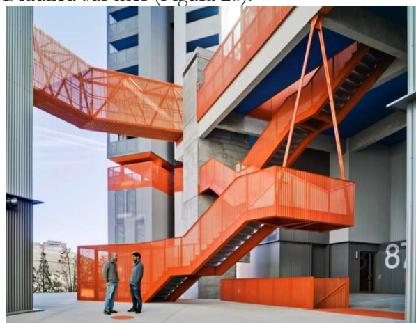
Figura 25. Escalera atirantada en edificio de 118 viviendas en Coslada.
