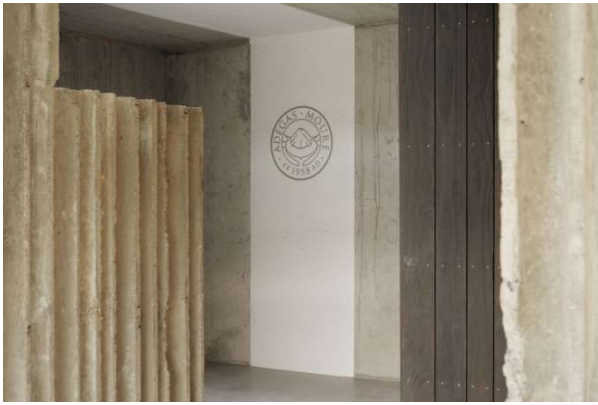
Figura 6. Tratamientos superficiales en hormigones vistos.
