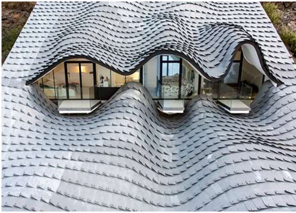
Figura 20. Geometría irregular de la cubierta de la vivienda.
