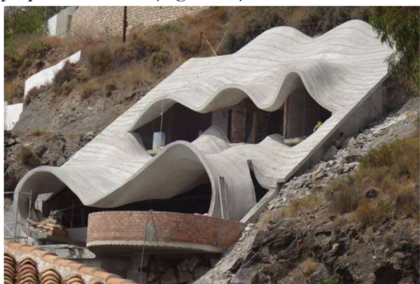
Figura 23. Estructura de hormigón de cubierta.
