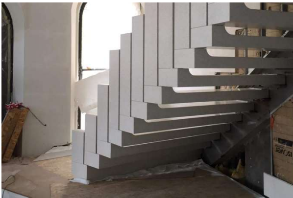
Figura 28. Escalera de terrazo estructural en vivienda en Beaulieu sur Mer, Francia.
