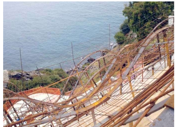
Figura 22. Pletinas de acero predeformadas que constituyen las líneas maestras de la geometría.
