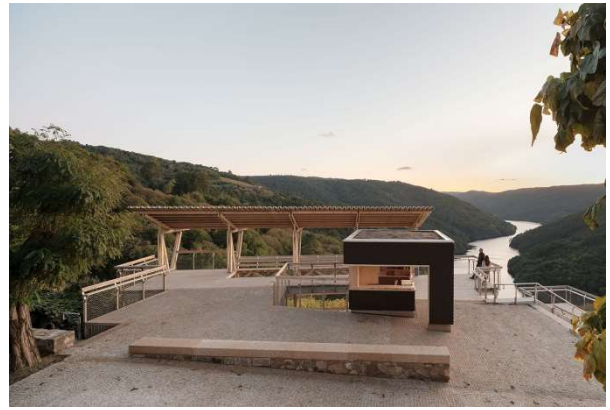
Figura 4. Vista general de la estructura del mirador.
