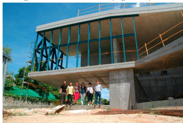
Figura 15. Vista general de la estructura del voladizo.
