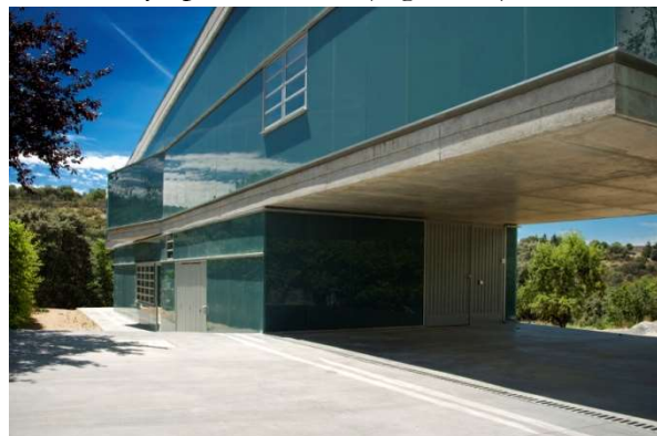
Figura 12. Casa de las hormigas en Collado Villalba.
