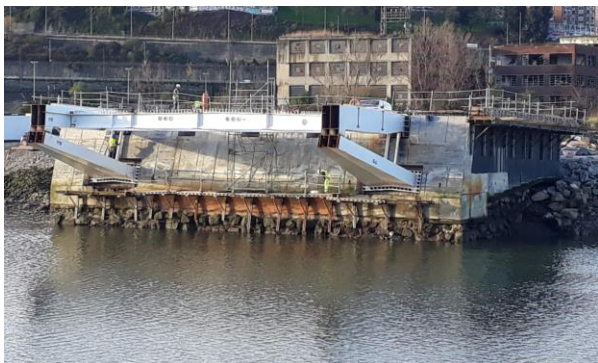
Figura 9. Ejecución de arranques
