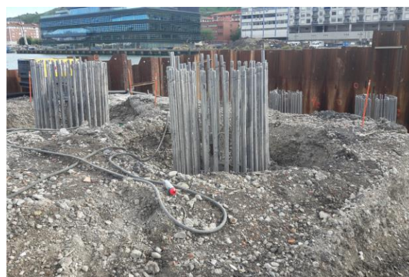
Figura 7. Ejecución de la cimentación de la margen izquierda
