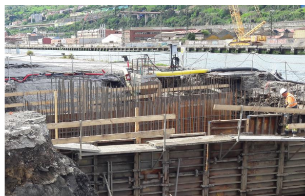
Figura 8. Ejecución de la cimentación de la margen derecha
