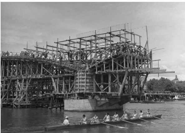
Figura 1. Puente durante la construcción.
