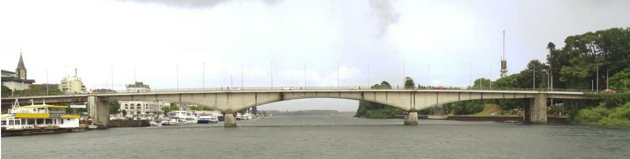
Figura 3. Panorámica del Puente Pedro de Valdivia.
