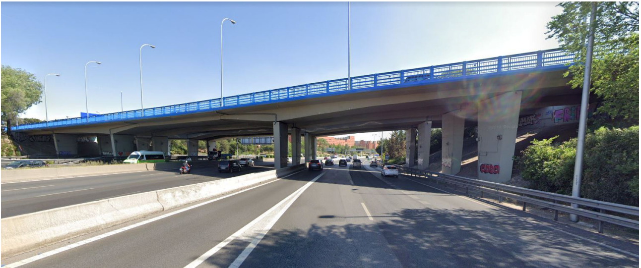
Figura 20. Vista lateral de la estructura ya rehabilitada.
