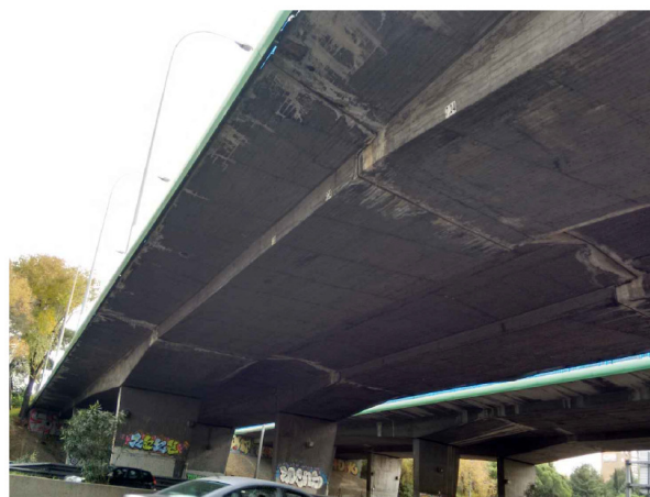
Figura 4. Vista inferior previa a la rehabilitación.
