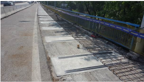
Figura 18. láminas de refuerzo de fibra de carbono ya instaladas.
