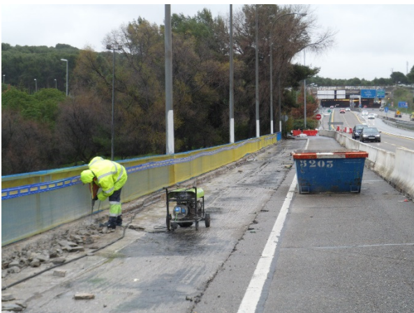
Figura 15. Fresado y demolición de la barandilla existente.
