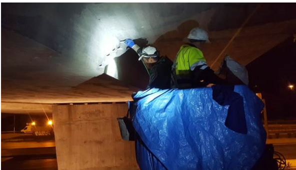
Figura 10. Imagen de inyección de fisuras (en corte nocturno).
