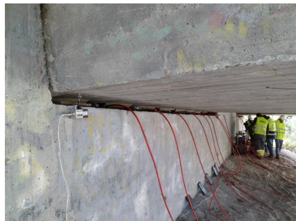
Figura 6. Vista de estribo, gatos hidráulicos instalados para maniobra de sustitución de apoyos.
