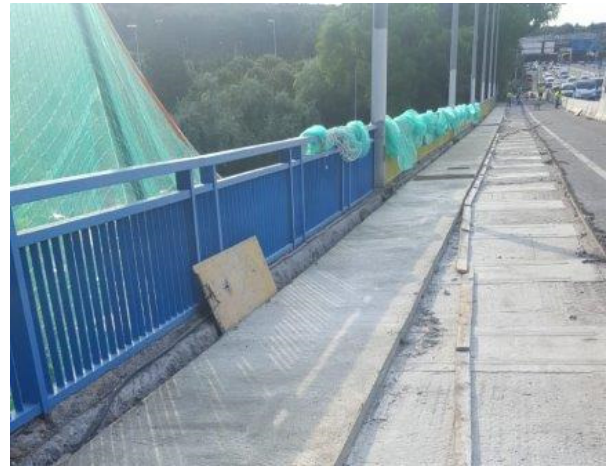
Figura 19. Nuevo zócalo de hormigón para apoyo y anclaje de la nueva barrera ya ejecutado.
