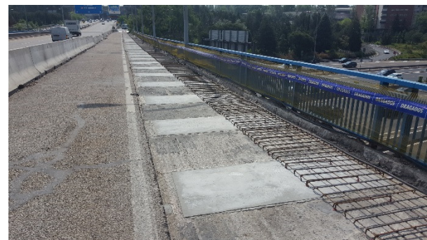
Figura 16. Capa de mortero de nivelación ya ejecutada. Armado para el nuevo zuncho ya colocado.
