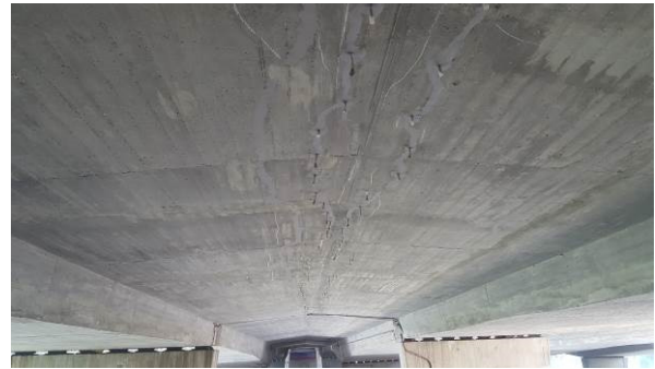
Figura 11. Vista inferior de tablero, con fisuras ya inyectadas.
