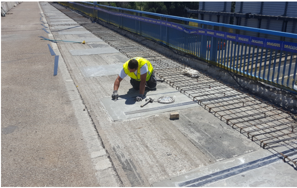
Figura 17. Colocación de las láminas de refuerzo de fibra de carbono.
